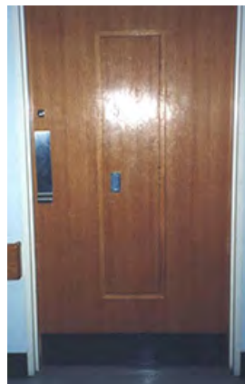
Door, Hallway Side
