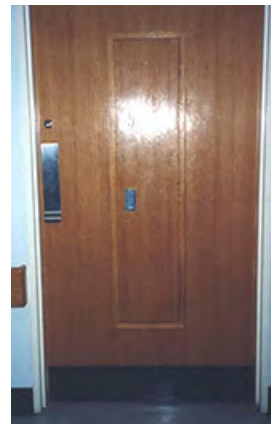
Door, Hallway Side
